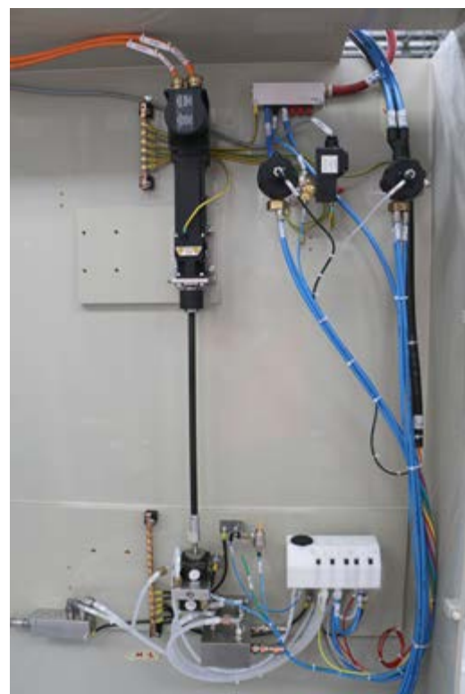
Exemple d'un système isolé
